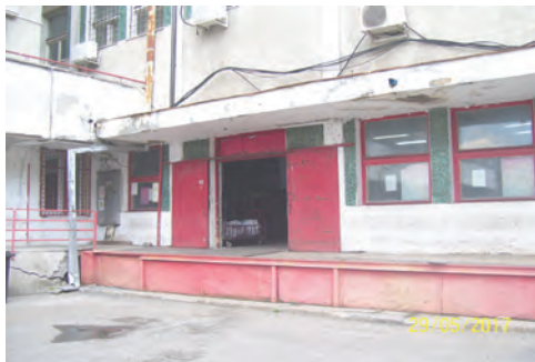
înainte de renovare
